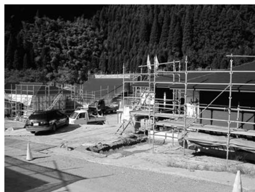
矢部村に建設中の山村滞在施設
