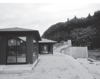
建設中の矢部地区山村滞在施設
