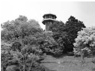
③解体予定の展望台
