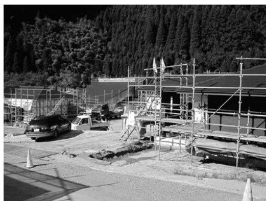
矢部村に建設中の山村滞在施設
