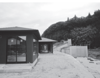
建設中の矢部地区山村滞在施設
