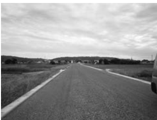
④稲富地区道路整備箇所
