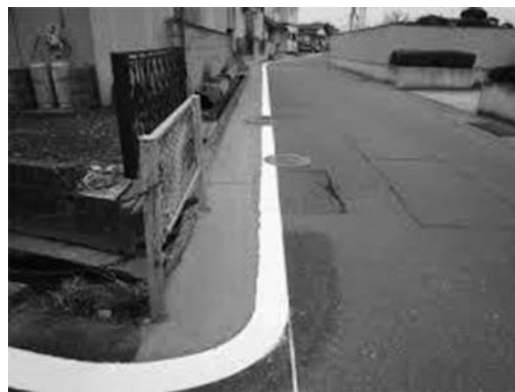
グリーンベルト施工例
