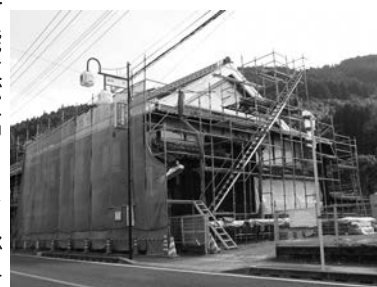
修復が進む伝統的建造物
