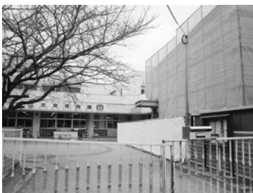
建設中の忠見保育園
