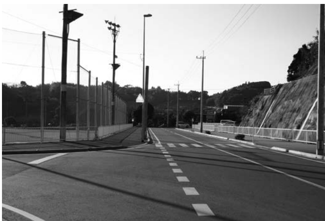
事業延長が予定されている国道442号黒木バイパス
