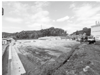
新校舎の建設予定地
