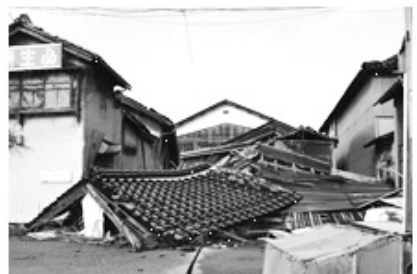
能登半島地震で被災した家屋 (石川県珠洲市飯田町)
