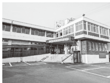
昭和35年建築の上陽支所
