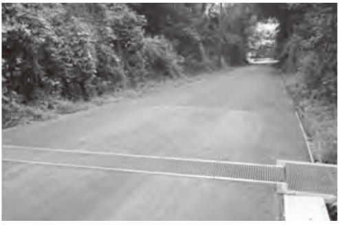
段差改良工事と支障木伐採が実施された 市道渡内鹿子生線
