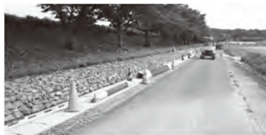
堤防強化工事が進む矢原付近(令和7年6月)
