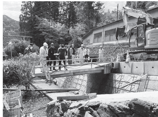
市道田代・タシノ尾線・田代川 復旧工事の調査の様子
