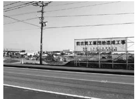
工事が進む前古賀工業団地
