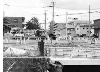
国道3号吉田交差点改良工事
