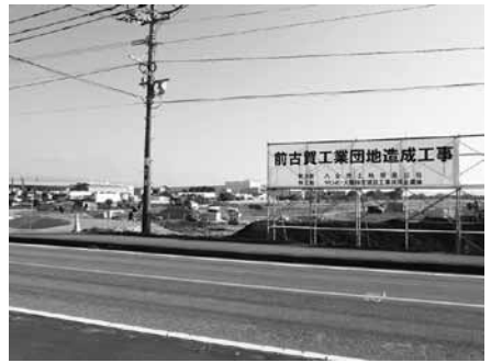
工事が進む前古賀工業団地
