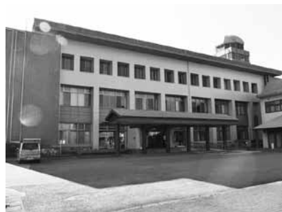
老朽化が進む立花庁舎
