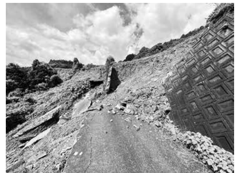
農地と農道が崩落した被災現場
