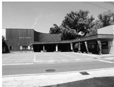
改修前のほたと石橋の館
