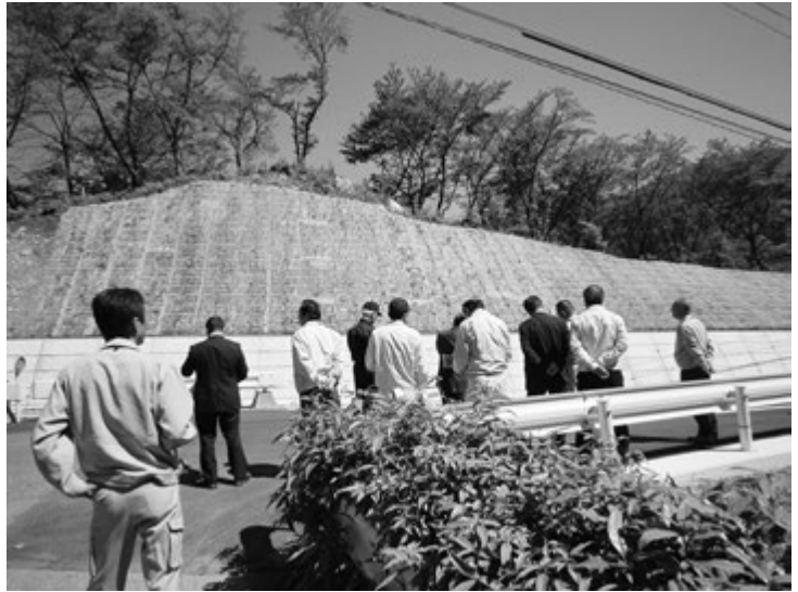
①池の山キャンプ場入口付近拡幅現場
