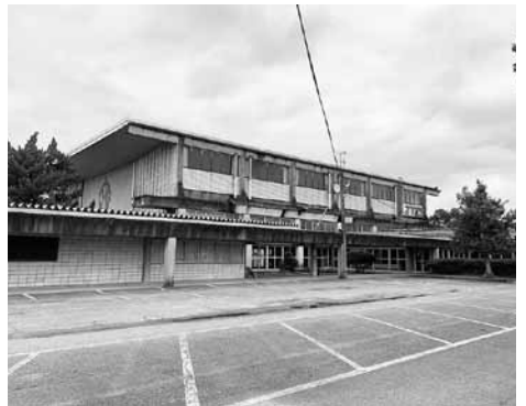
築53年が経過した立花体育館
