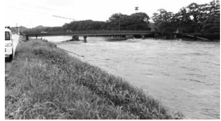
R1 矢部川増水写真（中川原橋）
