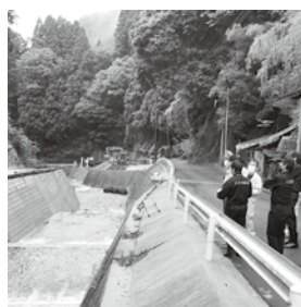
熊渡川河川改良工事箇所
