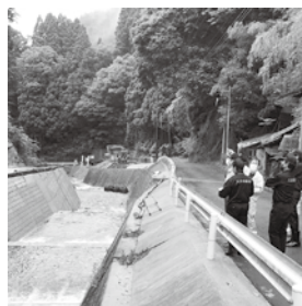
熊渡川河川改良工事箇所
