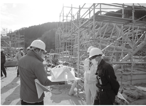
建設中のキャンプ施設を前に説明を受ける
