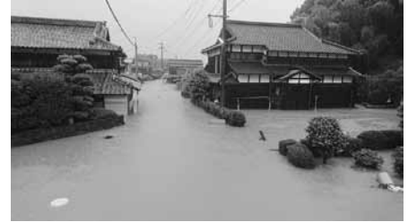
山下地区の内水氾濫状況 7月6日午後6時半頃
