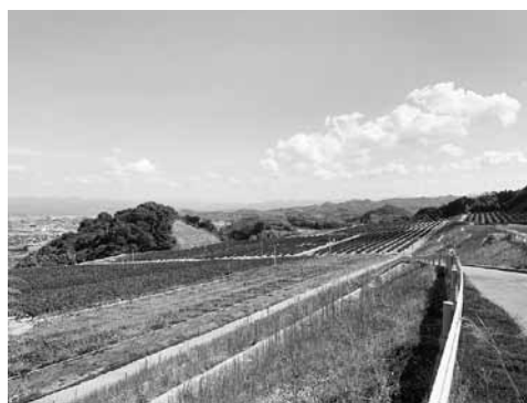
県営中山間地域農村活性化総合整備事業により整備された立花2期地区(山下地区)の農業団地
