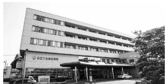
公立八女総合病院外観
