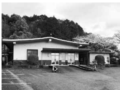
老朽化した黒木斎場
