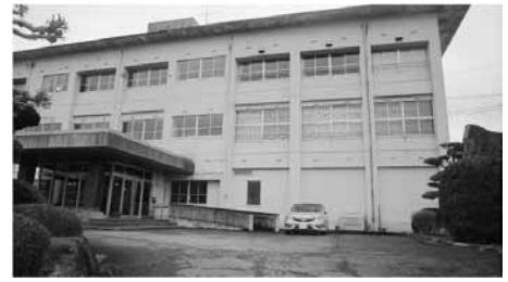
川崎小学校現況
