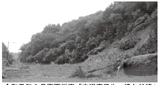
令和元年8月豪雨災害「市道鹿子生・遠久谷線」
