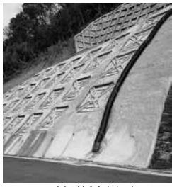
星野林道被災地の復旧現場
