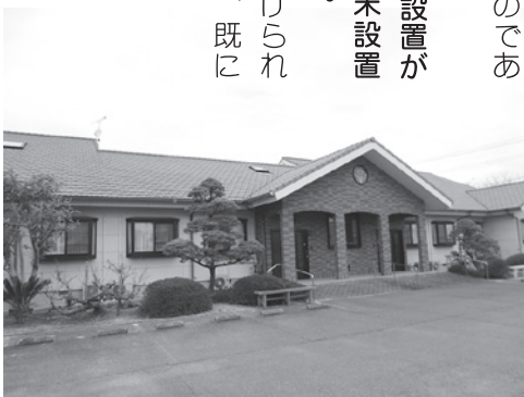
改修を予定しているグループホーム
