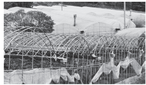
被害を受けたビニールハウス
