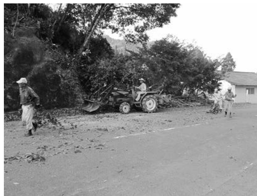
県道の影切り作業中
