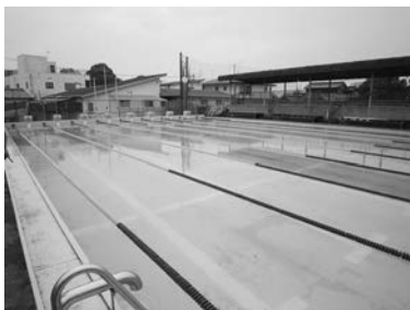
▲福島中学校プール
