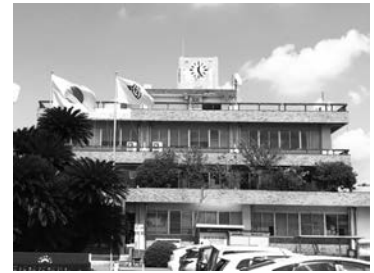
八女市役所本庁舎
