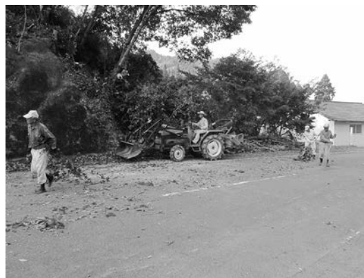
県道の影切り作業中
