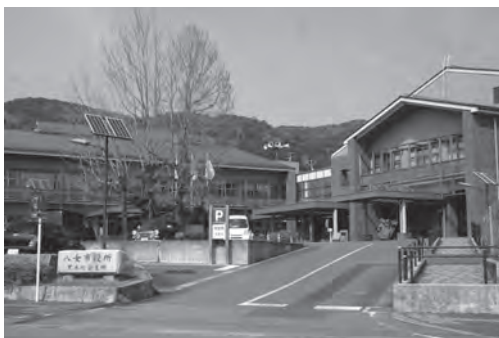
八女市役所黒木総合支所
