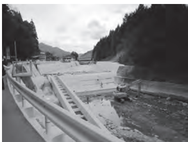
頭首工の復旧 (星野村十箆地区)
