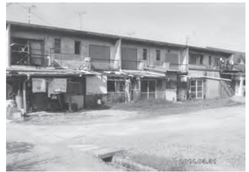
昭和29年建築の市営住宅
