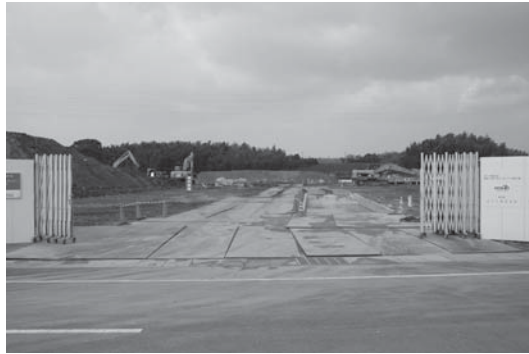
ホクト株の第2工場建設始まる
