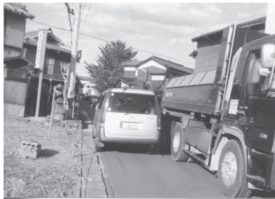
県道 船小屋、八女線(川犬地内)
