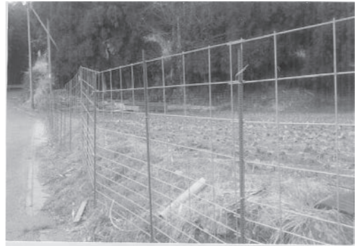
設置されたイノシシ侵入防止柵
