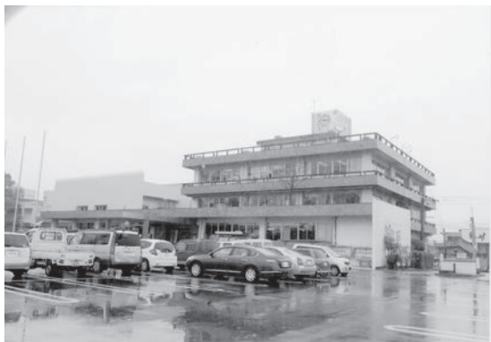
八女市役所本庁舎
