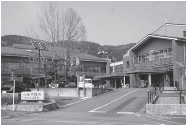
八女市役所黒木総合支所
