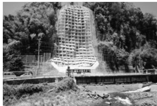
②国道442号宮野尾橋架け替え予定現場
