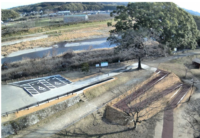
図 宮野公園 バリアフリー通路・駐車場
