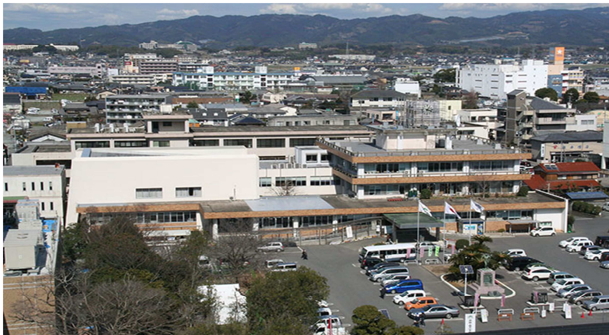
(写真) 八女市役所 本庁舎
