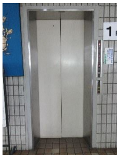
幅が狭いエレベーター
