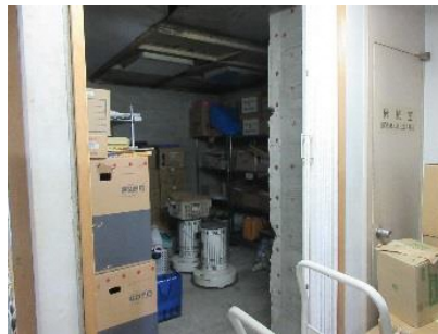
機械室として使われていた部屋を 物置として利用
