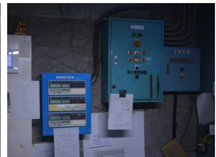
建設当時のままの古い設備
