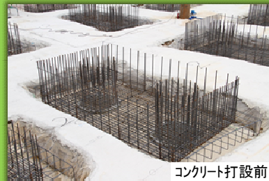
コンクリート打設前
