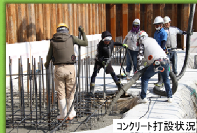
コンクリート打設状況
