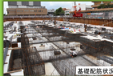
基礎配筋状況
