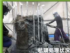
杭頭処理状況
