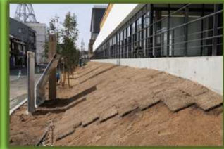
浸水対策で新庁舎1階床面は周辺道路より約1.2m高い。南側法面は芝張り。
