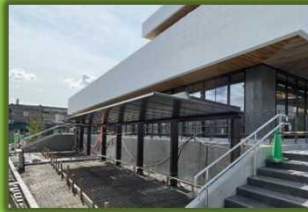
新庁舎の東面(福島小学校側)では、駐輪場の施工が進んでいます。
