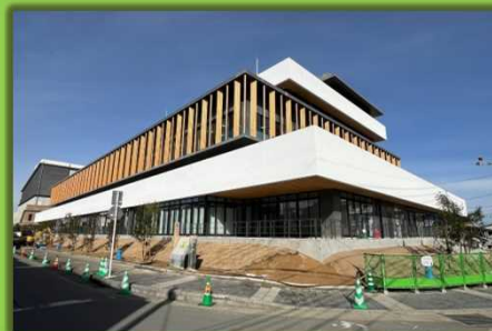
新庁舎南東角(福島小学校側)交差点より
