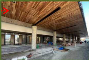
新庁舎正面の大庇の天井には八女産の杉を仕上材として使用しています。
