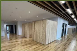
相談や来客用のブースの囲いにも、八女産の杉を使用しています。
