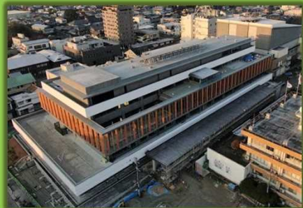
新庁舎棟工事全景(令和6年1月29日 ドローン撮影)
