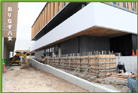
新庁舎南西角。南側道路から庁舎へのスロープ工事
