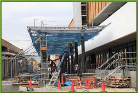
新庁舎の正面となる北側の大庇工事
