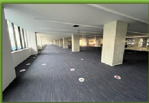
2階 執務室のOAフロア部の床仕上げ工事。カーペットが敷き詰められました。
