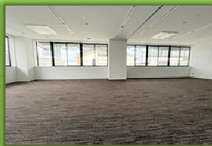
2階 会議室や倉庫など個室は、天井、壁、床の仕上げ工事が進んでいます。
