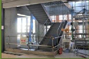
建物内の中央の鉄骨階段も取り付けられました。
