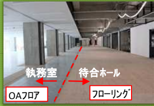
1・2階は床下地まで完了し、今月中旬に2階からフローリング工事を開始します。
