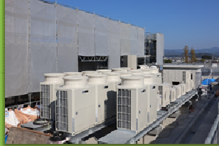
5階バルコニーには、大型の空調機器等の設置工事が進んでいます。
