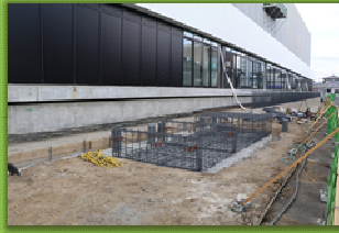
庁舎南側も外構工事が進んでおり、受水槽などの基礎工事が行われています。
