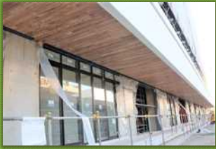
不燃処理を施した「八女スキ」を、軒裏の仕上材に使用しています。
