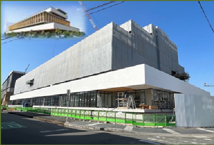
新庁舎南東角交差点より（左上は設計時の完成パース）
