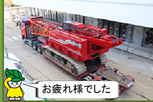
約1年4ヶ月、現場で活躍した90tクローラークレーンが解体され搬出されました。
