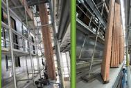
⑧外部足場の間に吊るして落 ⑨取付が完了した木製ルーハとし込み、プレートに差込みます。全部で200ヶ所設置します。
