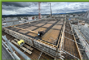
5階 最上階屋根の鉄筋組立状況
