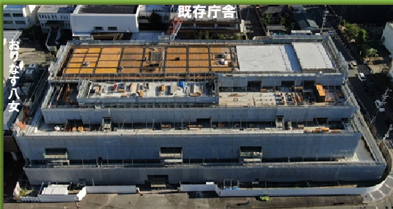
新庁舎棟工事全景(令和5年8月28日 ドローンにて撮影)
