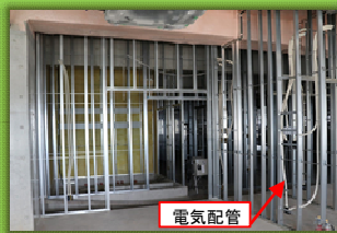
3階 内部の壁の下地が組み立てられ、電気配管等を通す工事も並行して実施されています。
