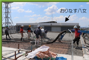
5階 最終工区のコンクリート打設状況 (※奥の建物はおりなす八女屋上)
