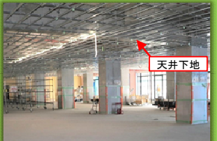
1階 天井内の配管や配線工事が終わり、天井を貼るための下地が組まれています。
