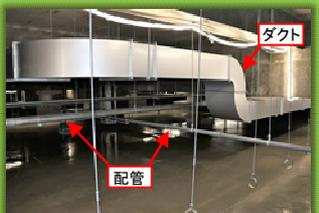
2階(免震階) 配管や配線、空調のダクトなどが立体的に交差され設置されています。
