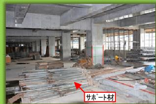
2階 大量の型枠・サポート材の撤去が始まりました。7月中旬から内装工事に入ります。
