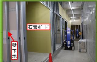
1階 内部の壁も工事が進んでいます。軽量鉄骨の下地に石膏ボードを貼って壁を作ります。
