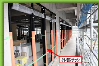
1階 外部サッシが取り付けられました。作業でキズが入らないように養生されています。
