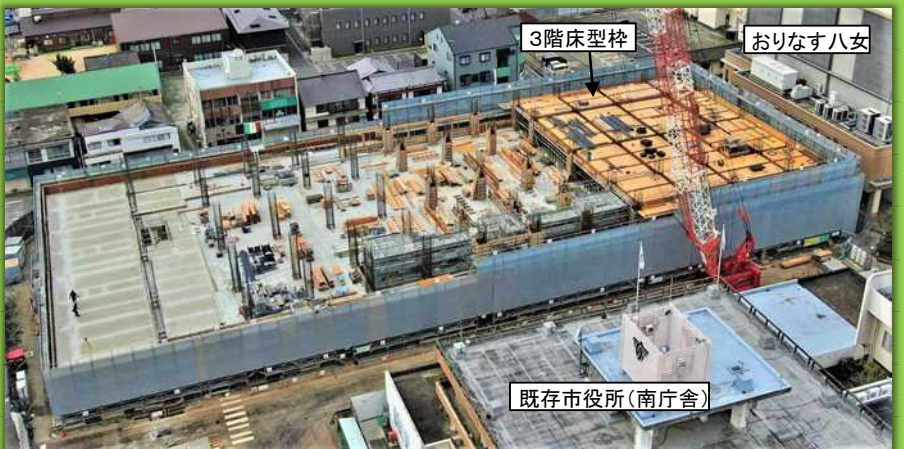
新庁舎棟工事全景 (令和5年3月31日 市役所敷地上空より)
