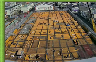
オレンジの部分は2階の床の型枠です。(令和5年2月27日 おりなす八女屋上より)
