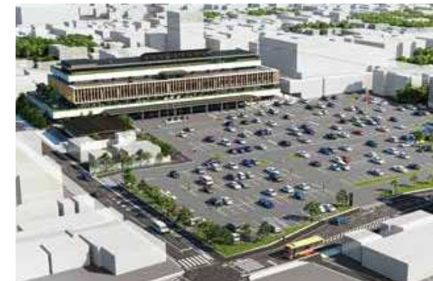
●北東からの全景イメージ
