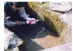
水路のひび割れ補修
