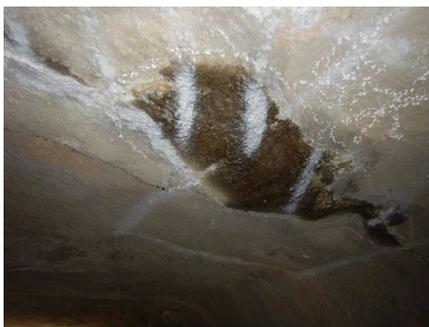
熊の内隧道（覆工の漏水：Ⅱb）
