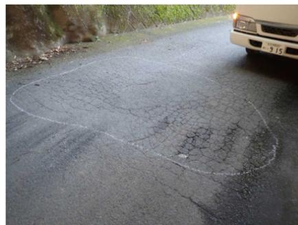
鳥越トンネル（舗装のひびわれ：Ⅱb）
