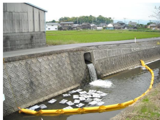
■油流出事故の拡散防止対策例
