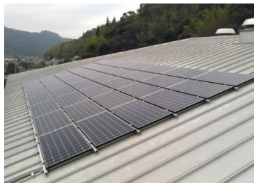
■ 星野中学校の太陽光発電パネル
