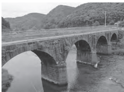
歩道として保存される宮ヶ原橋
