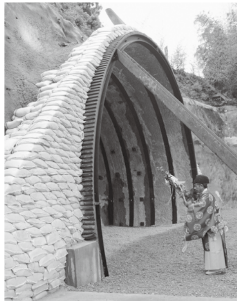
工事の安全を祈願しました
